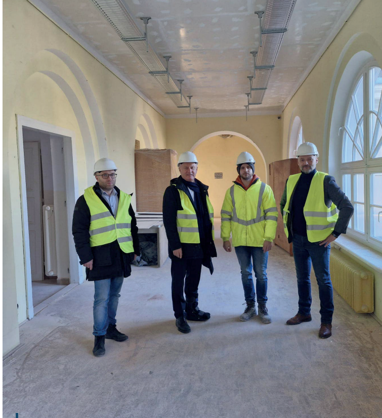
Trwa remont ponad 350-letniego Gmachu Głównego. Na placu budowy często pojawia się rektor KUL, ks. prof. Mirosław Kalinowski, aby nadzorować postęp prac.
